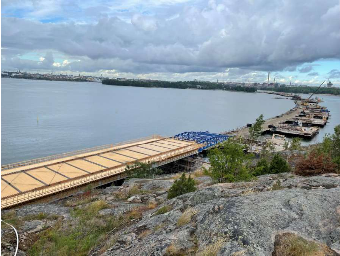
Kuva 2. Kruunusillan siltatyömaa idästä päin Kruunuvuorenrannasta kuvattuna (kuva: Kruunusillat -hanke).
